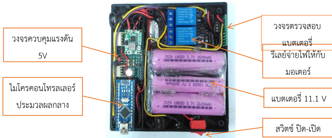
ภาพที่ 5 การติดตั้งอุปกรณ์และวงจรชุดควบคุมการทำงาน
