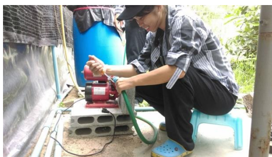
ภาพที่ 5 การติดตั้งปั้มน้ำ
