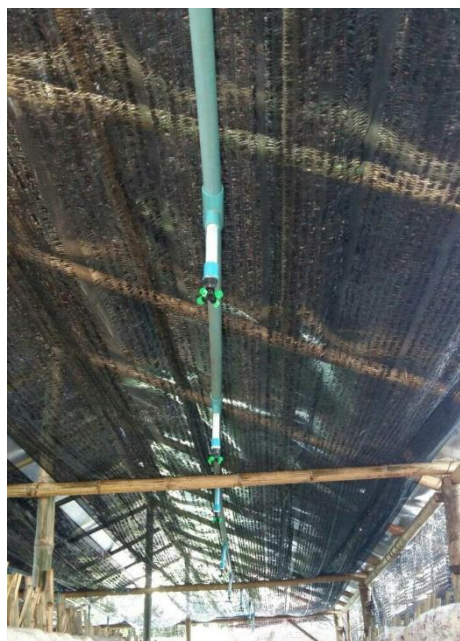
ภาพที่ 3 การติดตั้งท่อน้ำและหัวพ่นหมอก
