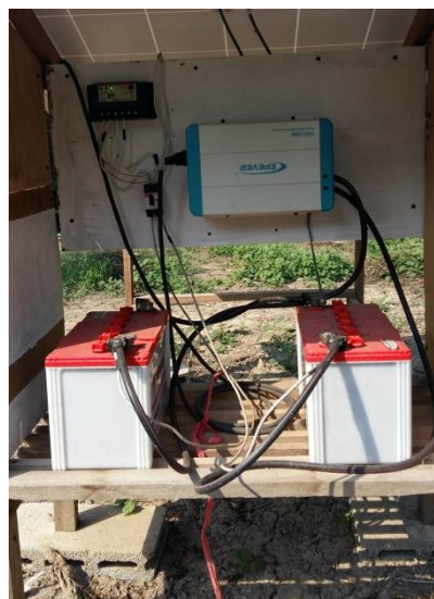
ภาพที่ 7 การติดตั้งระบบชาร์จและแปลงกระแสไฟฟ้า
