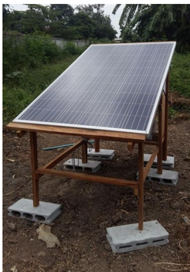
ภาพที่ 6 การติดตั้งแผงโซลาเซลล์
