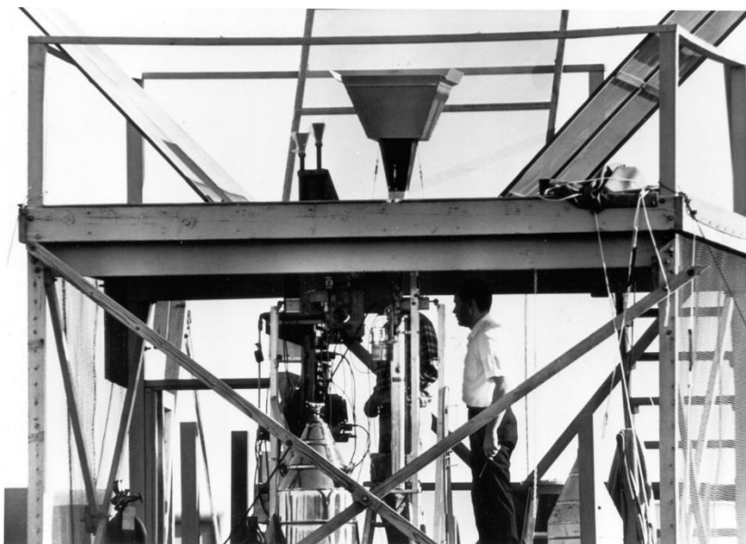
รูปที่ 6 David Wilkinson (คนเสื้อสีขาว) และ Peter Roll กำลังติดตั้งการทดลองตรวจวัดรังสีไมโครเวฟพื้นหลังหลักฐานของทฤษฎีบิกแบงที่บนคาบฟ้าของอาคาร Guyot Hall ตึกสาขาธรณีวิทยา โครงไม้ที่เห็นคือกรงนกพิราบเก่า ส่วนที่คล้ายทรมเป้รูปเหลี่ยมด้านบน คือ ฮอว์ก ที่พวกเขาออกแบบสำหรับการรับสัญญาณ CMB (เครดิตภาพ: Robert Matthews circa 1964-65)
