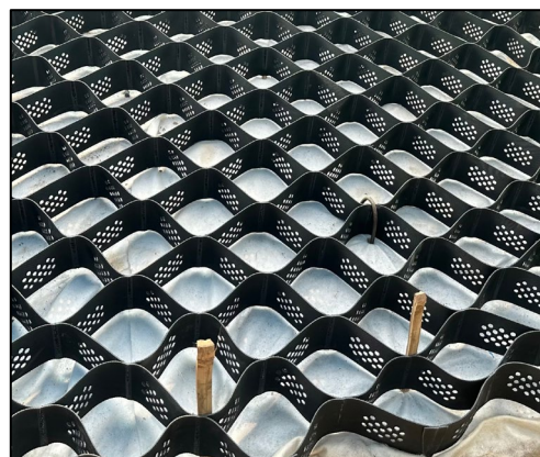
รูปที่ 5 : วัสดุสังเคราะห์แบบตาข่ายรังผึ้งจากโครงการซ่อมแซมคันดินอ่างเก็บน้ำตาตมพู่ จังหวัดเชียงใหม่
