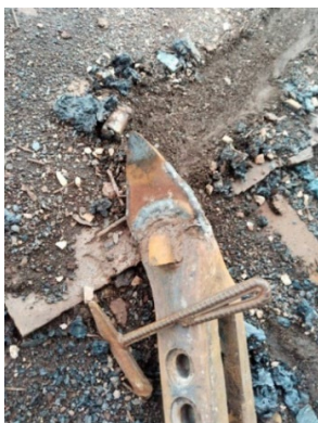
รูปที่ 7: การตัดหรือเลาะวัสดุเสริมแรงเดิมที่เหลืออก
