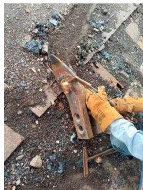
รูปที่ 7: การตัดหรือเลาะวัสดุเสริมแรงเดิมที่เหลืออก
