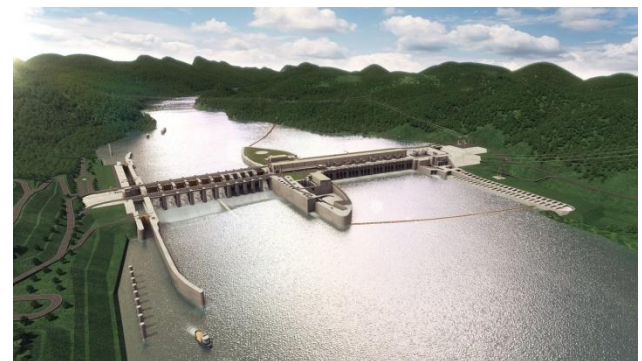
รูปที่ 1.1 โครงการไฟฟ้าพลังน้ำไซยะบุรี
