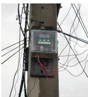
รูปที่ 8 การแสดงสถานะกำลังไฟฟ้า และกระแสไฟฟ้า ของเฟส A, B และ C ที่จุดทดสอบ และเก็บข้อมูล
