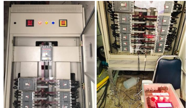
ก) เครื่องมือวัดมาตรฐาน ข) การติดตั้งทดสอบเทียบค่า รูปที่ 4 การสอบเทียบชุดแสดงสถานะ กับตู้ระบบไฟฟ้า MDB
