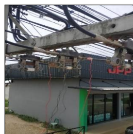
รูปที่ 7 การติดตั้งชุดแสดงสถานะที่หม้อแปลงไฟฟ้า
