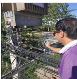
รูปที่ 7 การติดตั้งชุดแสดงสถานะที่หม้อแปลงไฟฟ้า
