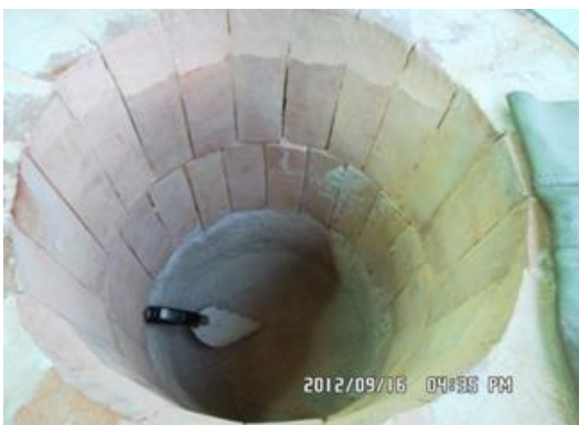
รูปที่ 4 เรียงอิฐทนไฟภายในเตาหลอม
