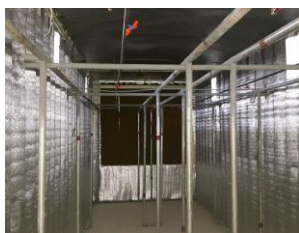
(ก) ด้านในที่แสดงติดตั้งระบบ EVAP
