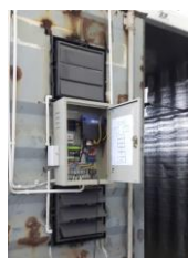
(ข) ด้านหลังที่มีการติดตั้งพัดลม และ ชุดควบคุม
