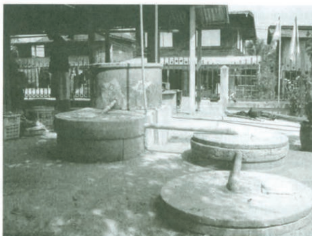
รูปที่ 2 ระบบบำบัดน้ำเสียชนิดดั้งเดิมที่บ้านทอไหมมัดหมี่ อ. ชนบท จ.ขอนแก่น (บ้านนางแดง จ้างพิพัฒน์)
