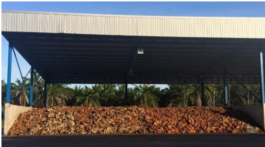
ภาพที่ 1 โรงเรือนแบบที่อากาศถ่ายเทได้สะดวก
