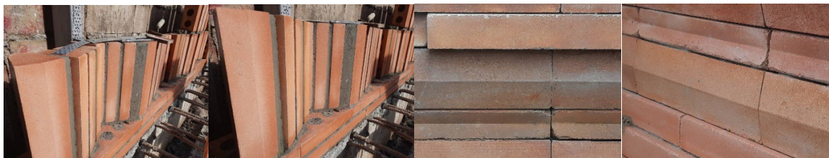
รูปที่ 8 การทดลองก่อผนังอิฐได้ทำการทดลองทั้งการวางอิฐแนวตั้งและแนวนอน โดยใช้อิฐที่มี 4 รู ประกอบเพื่อศึกษาความเป็นไปได้ในการก่อสร้างและรูปแบบลวดลายที่เกิดขึ้น
