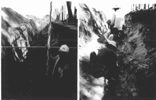
รูปที่ 2 แสดงการเปิดหน้าดินบริเวณชายหาดหรือบริเวณจุดขึ้นบก (Landing Point)
