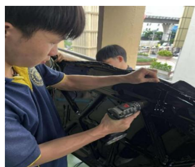
รูปที่ 10 แสดงการติดตั้งอินเวอร์เตอร์
