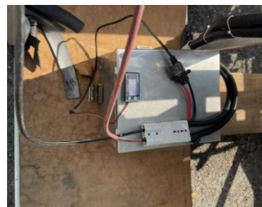
รูปที่ 13 แสดงการติดตั้งแผงโซลาร์เซลล์เข้ากับโหนด
