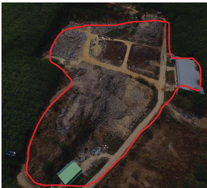
รูปที่ 1 บ่อขยะเทศบาลตำบลศาลาด่าน อ.เกาะลันตา จ.กระบี่ ที่มา: สำนักปลัดเทศบาลตำบลศาลาด่าน
