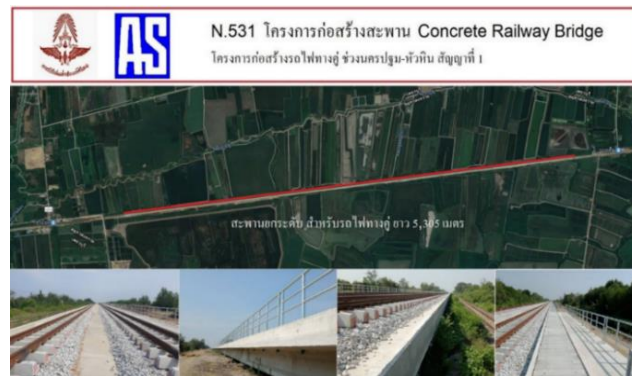
รูปที่ 1 โครงการก่อสร้างสะพาน Concrete Railway Bridge ช่วงสถานี บางเค็ม - เขาย้อย
