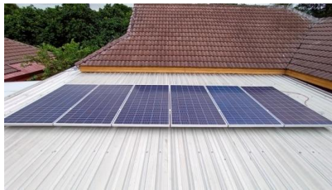
รูปที่ 4 การติดตั้งแผงโซลาร์เซลล์บนหลังคาเมทัลชีต
