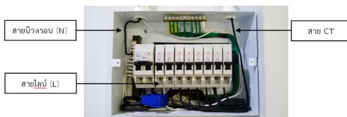
รูปที่ 5 การเชื่อมต่อระบบผลิตกระแสไฟฟ้าพลังงานแสงอาทิตย์เข้ากับระบบการไฟฟ้า
