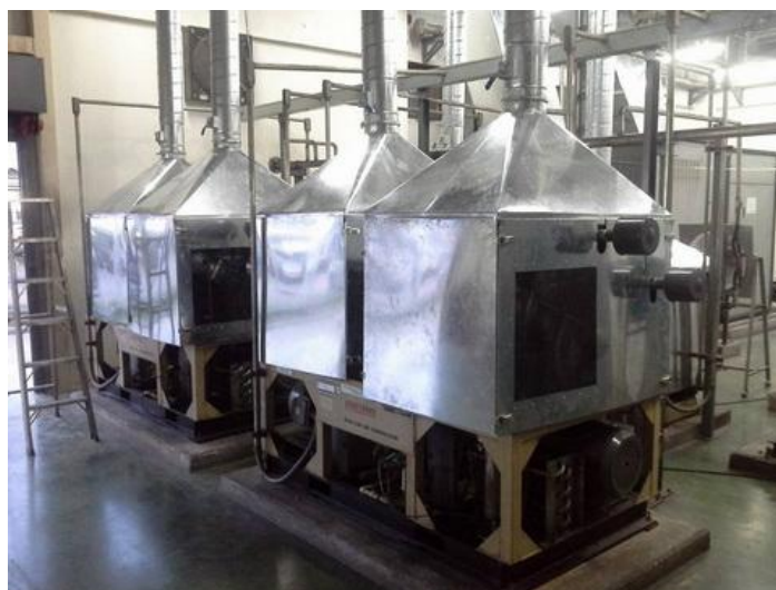
รูปที่ 7 การติดตั้ง Hood ครอบชุดเครื่องอัดอากาศแบบลูกสูบชนิดความดันสูง
