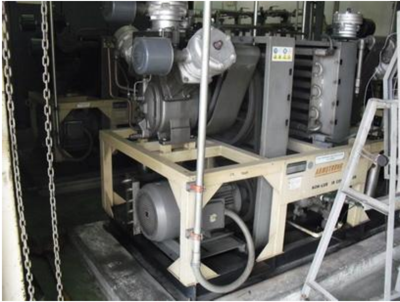
รูปที่ 3 เครื่องอัดอากาศแบบลูกสูบชนิดความดันสูง
