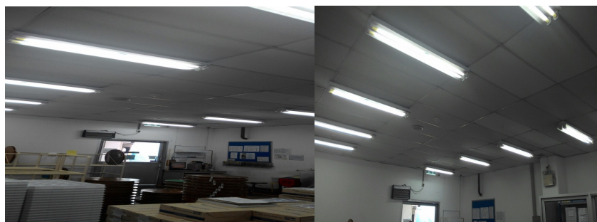
รูปที่ 8 มาตรการเปลี่ยนหลอดฟลูออเรสเซนต์ T8 ขนาด 36 W เป็นหลอด LED ขนาด 14 W
