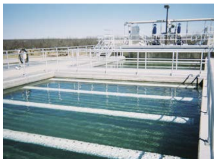
รูปที่ 2. ถังตกตะกอนแบบควบคุมชั้นตะกอน (superpulsator) (Degremont Technologies, 2018)
