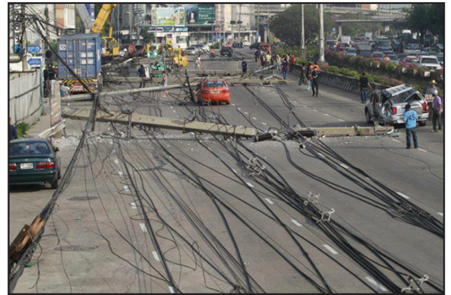
ภาพที่ 1 ตัวอย่างการภาพเหตุการณ์รถเครนเกี่ยวสายไฟฟ้าทำเสาไฟฟ้าหัก 33 ต้นในกรุงเทพฯ [6]
