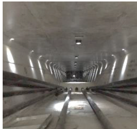
รูปที่ 4 ชิ้นส่วน Deviator segment
