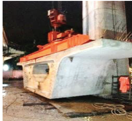
รูปที่ 3 ชิ้นส่วน Pier segment
