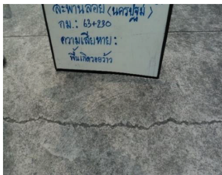
ข) โครงสร้างคอนกรีตเกิดรอยร้าวและเหล็กเกิดสนิม
