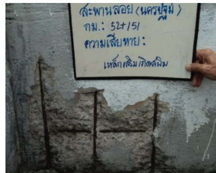
ข) โครงสร้างคอนกรีตเกิดรอยร้าวและเหล็กเกิดสนิม
