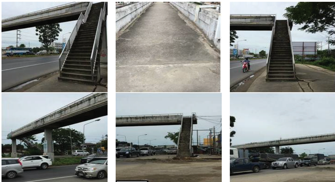
รูปที่ 2 สิ่งแวดล้อมรอบข้างและสภาพทั่วไปของสะพานลอยในเขตชุมชนจังหวัดนครปฐมที่ใช้ศึกษาในครั้งนี้
