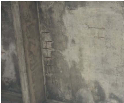
ก) เหล็กเสริมท้องพื้นและคานสะพานลอยเกิดสนิม
