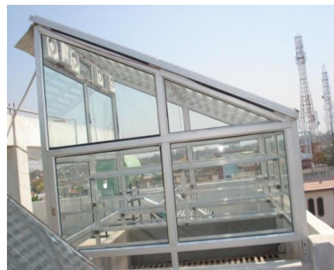
รูปที่ 6 การใช้โมดูลโฟโตวอลเทอิก/ความร้อนในห้องอบแห้งแบบเรือนกระจก [29]
